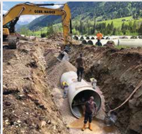
Bis zu sechs Rohre konnten pro Tag verlegt werden
