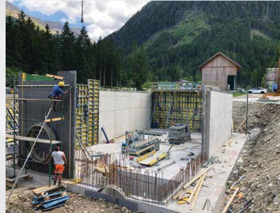
Das Sammelbecken wird herausgeschalt
