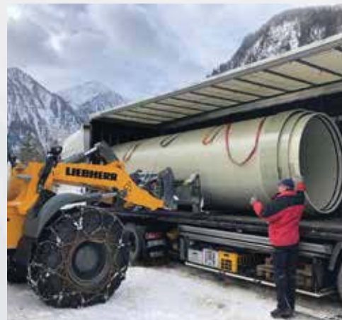
Lieferung der Rohre: 190 cm, 180 cm, 170 cm Durchmesser
