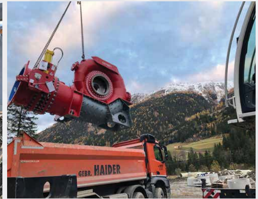
Verladung einer acht Tonnen schweren Francis-Turbine
