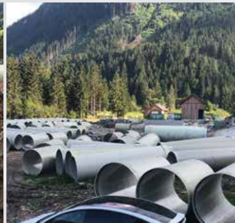
Die GFK-Rohre am Lagerplatz – 3400 Meter insgesamt
